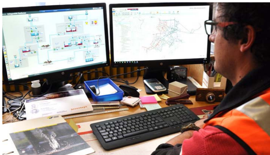
Der Brunnenmeister kann am Computer die Pumpen und Reservoirs überwachen.
